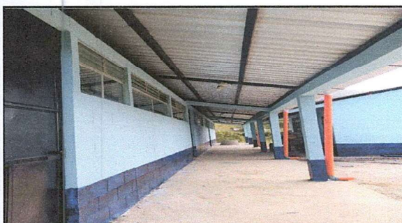
FOTO 3: SUSTITUCIÓN DE ESTRUCTURA DE MADERA POR METAL
