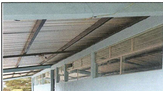
FOTO 4: SUSITUCIÓN DE MADERA POR METAL
