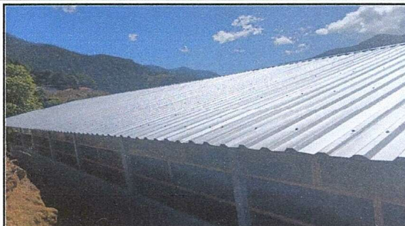
FOTO 2: SUSTITUCIÓN DE LÁMINA POR LAMINA TROQUELADA
