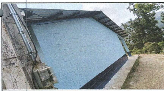
FOTO 5: PINTURA EN MUROS EXTERIORES E INTERIORES
