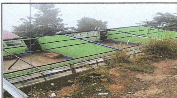
FOTO 3: SUSTITUCIÓN DE ESTRUCTURA DE MADERA POR METAL
