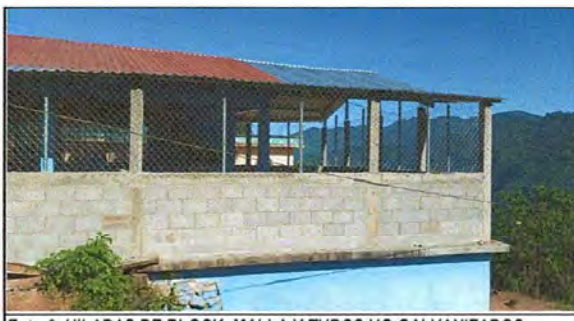
Foto 6. HILADAS DE BLOCK, MALLA Y TUBOS HG GALVANIZADOS
