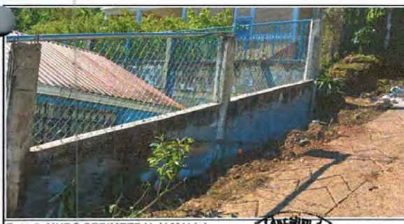
Foto 5. MURO PERIMETRAL Y MALLA
