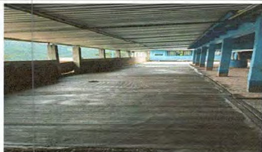
Foto 1: PISO TORTA DE CONCRETO
