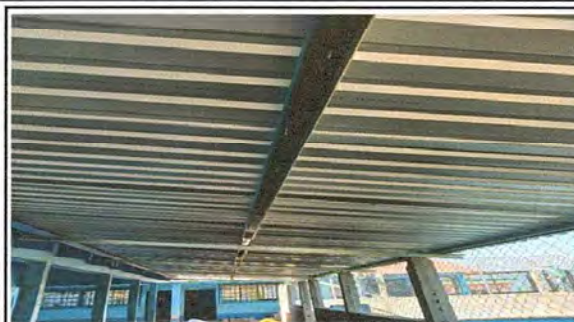
Foto 2: ESTRUCTURA DE SOPORTE DE METAL
