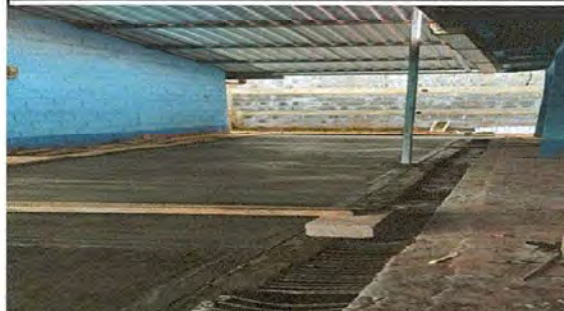
Foto 2: PISO TORTA DE CONCRETO
