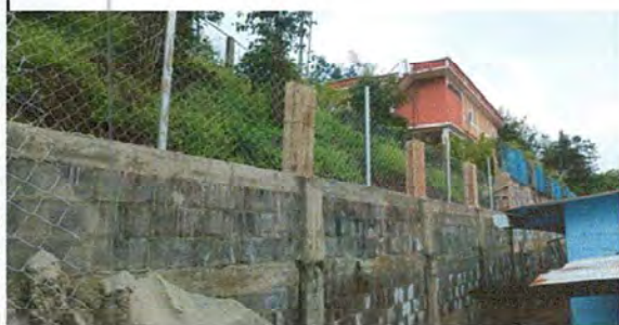
Foto 3: MURO PERIMETRAL, MALLA TUBO HG GAKVANIZADO
