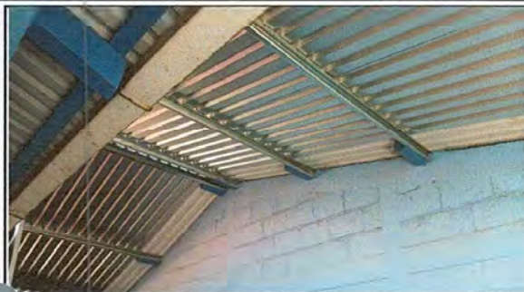
Foto 1: ESTRUCTURA DE TECHO
