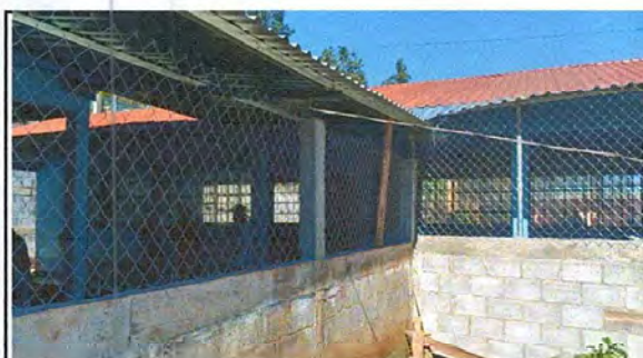
Foto 3. MURO PERIMETRAL, HILADAS DE BLOCK Y MALLA
