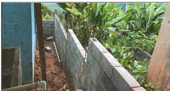
Foto 6: MURO PERIMETRAL DE BLOCK MALLA Y TUUBO HG
