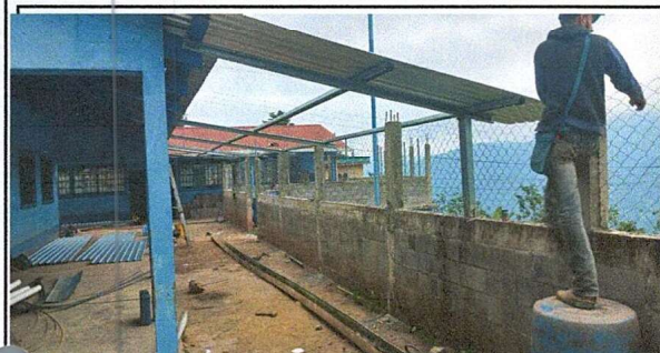
Foto 1 SUSTITUCION DE LAMINA POR LAMINA TROQUELADA CALIBRE 26
