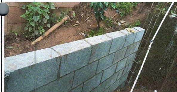
Foto 5 MURO PERIMETRAL DE BLOCK, MALLA Y TUUBO HG
