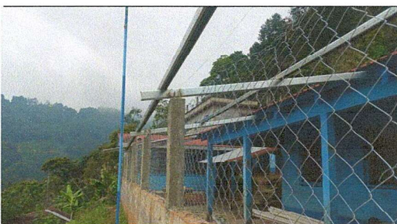
Foto 4: SUSTITUCION DE MURO PERIMETRAL DE BLOCK, Y MALLA
