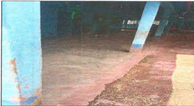
Foto1: SUSTITUCION DE TORTA DE CONCRETO POR TORTA DE CONCRETO
