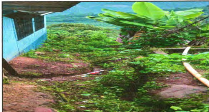
Foto1: SUSTITUCION DE BAJADAS PLUVIALES DE 3 PULGADAS
