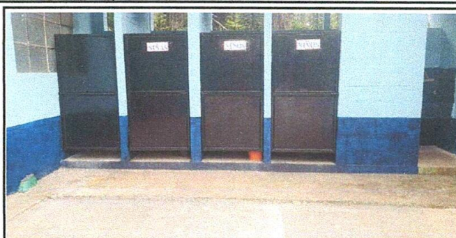
Pintura de paredes y puertas de metal de sanitarios realizado
