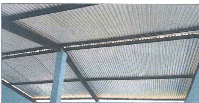
Mantenimiento de estructura de techo realizado
