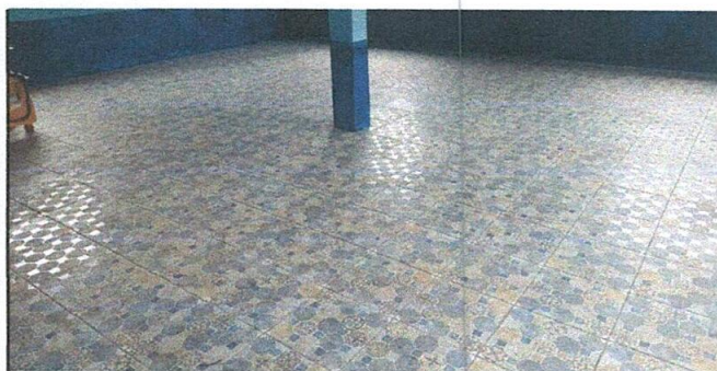
Colocación de piso cerámico en salón de comedor, realizado
