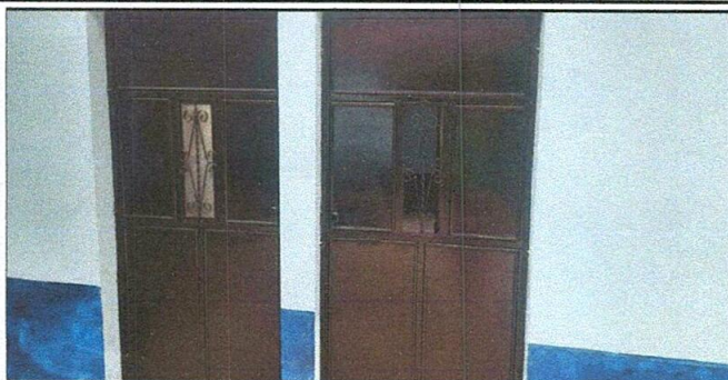
Pintura de puertas de metal y paredes realizado
