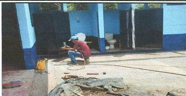
Pintura de puertas de metal en proceso
