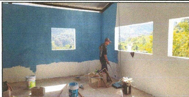
Pintura de paredes en proceso
