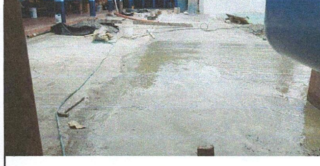
Colocación de torta de cemento en patio en proceso
