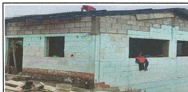
Levantado de pared y mantenimiento a estructura de techo en salón de comedor
