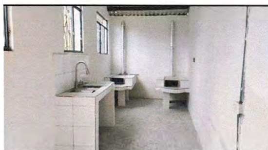
Foto 10: repellido de cocina
