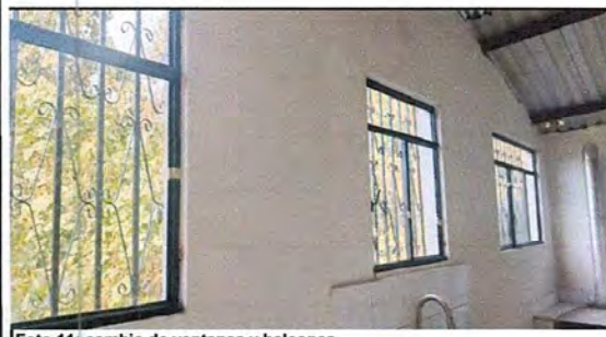
Foto 11: cambio de ventanas y balcones
