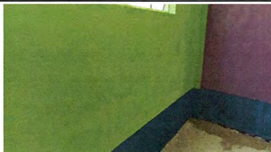
Foto 2: reparación de muro, por humedad.
