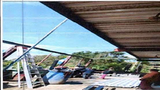
Foto 7: sustitución de laminas de cocina
