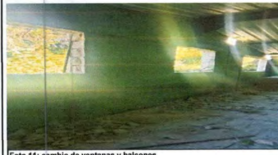
Foto 11: cambio de ventanas y balcones
