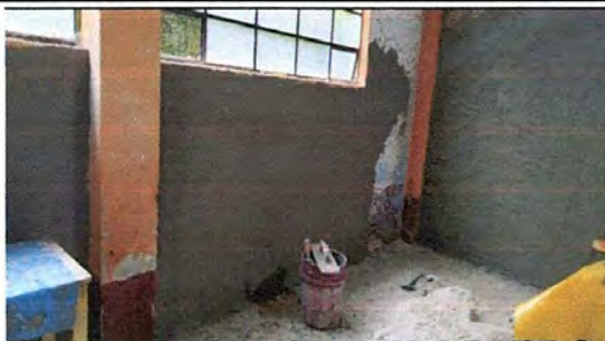
Foto 2: reparación de muro, por humedad.
