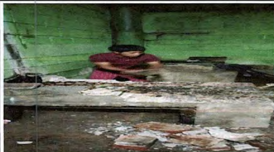
Foto 1: reparación de 2 pollos de cocina para servicios en cocina
