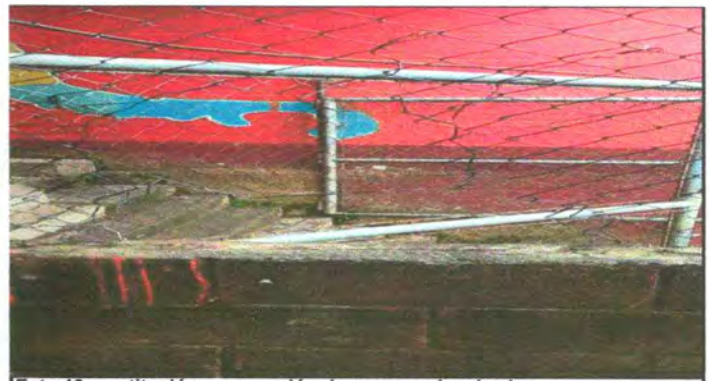
Foto 12: sustitución y reparación de mayas galvanizadas
