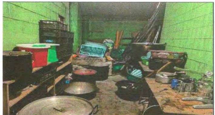
Foto 10: repellido de cocina
