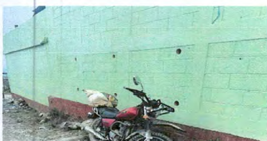
Foto 3: Pintura en muros exteriores e interiores
