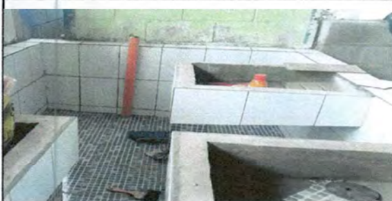
Foto 11: mejoramiento de azulejo en la pila
