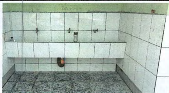
Foto 9: sustitucion de piso de granito en lavamanos
