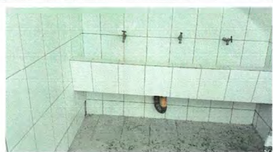
Foto 8: Mejoramiento de azulejo en lavamanos
