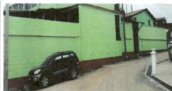
Foto 2: Pintura en muros exteriores e interiores
