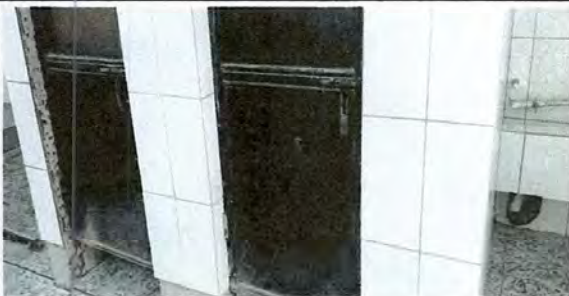
Foto 5: Mejoramiento de azulejos en baños
