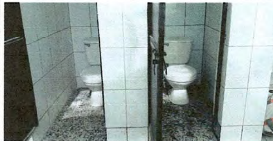
Foto 4: Sustrucción de inodoro
