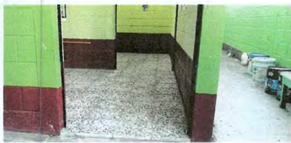
Foto 1: Sustrucción de piso de granito
