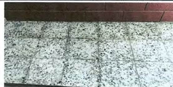
Foto 6: Sustrucción de piso de granito en cocina
