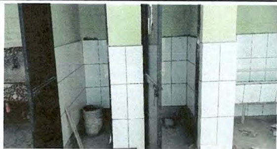
Foto 6: Sustitucion de inodoro
