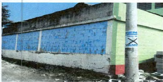
Foto 5: Pintura en muros exteriores e interiores
