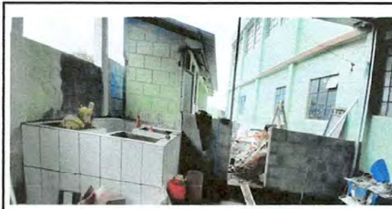
Foto 12: pared que separa el baño con cocina
