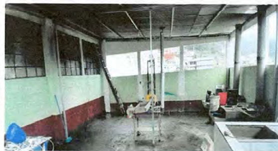
Foto 2: Sustitución de estructura de metal de ventana
