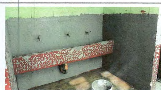
Foto 9: mejoramiento en azulejo en Lavamanos
