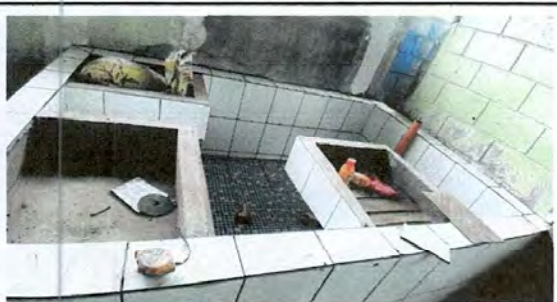
Foto 11: Mejoramiento de azulejo en pila
