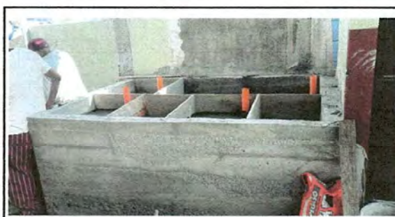
Foto10: sustitucion de pila
