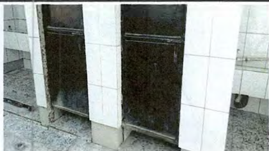
Foto 7: Mejoramiento de azulejos en servicio sanitarios
