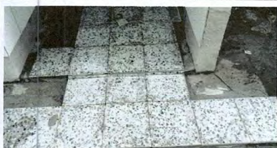
Foto 3: Sustitución de piso de granito
