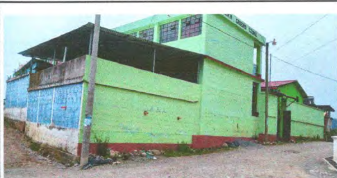
Foto 4: Pintura en muros exteriores e interiores
