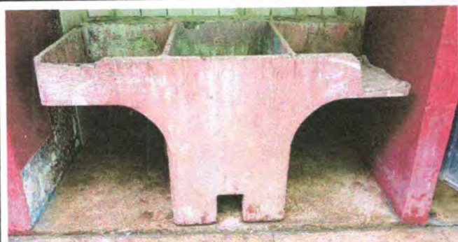
Foto 11: sustitución de pila
