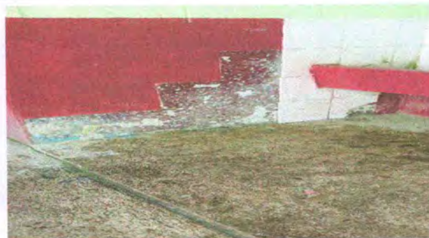
Foto 10: mejoramiento en azulejo en cocina
