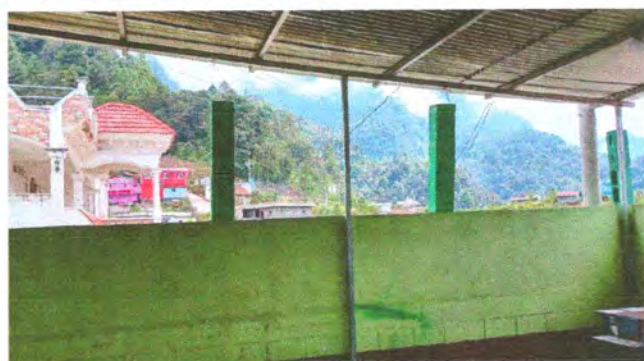
Foto 2: Sustitución de estructura de metal de ventana
