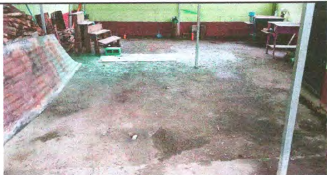
Foto 3: Sustitución de piso de granito
