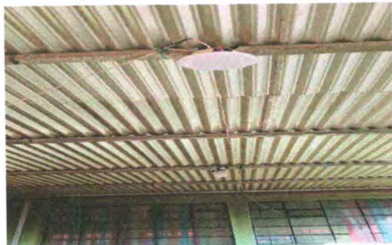
Foto 7: reparación en sistema eléctrico
