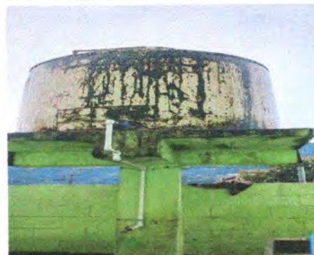
Foto 8: sustitución de depósito de agua
