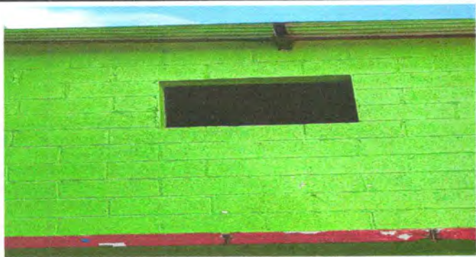
Foto1: Sustitución de estructura de metal de ventana
