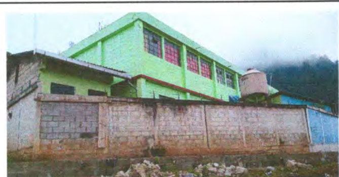
Foto 5: Pintura en muros exteriores e interiores
