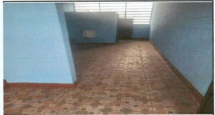
FOTO 4: REPARACIÓN DE PISO DE TORTA
