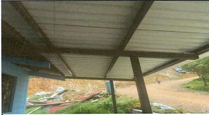
FOTO 1: SUSTITUCIÓN DE LAMINA
