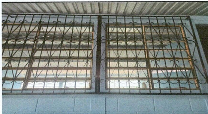
FOTO 3: MANTENIMIENTO A ESTRUCTURAS
