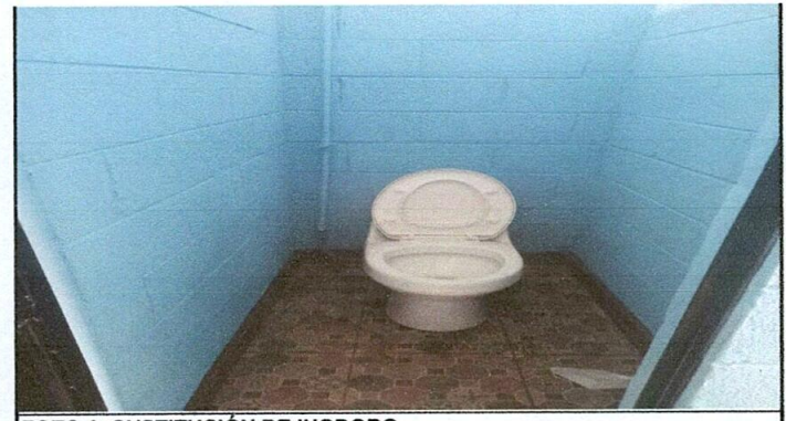
FOTO 6: SUSTITUCIÓN DE INODORO
