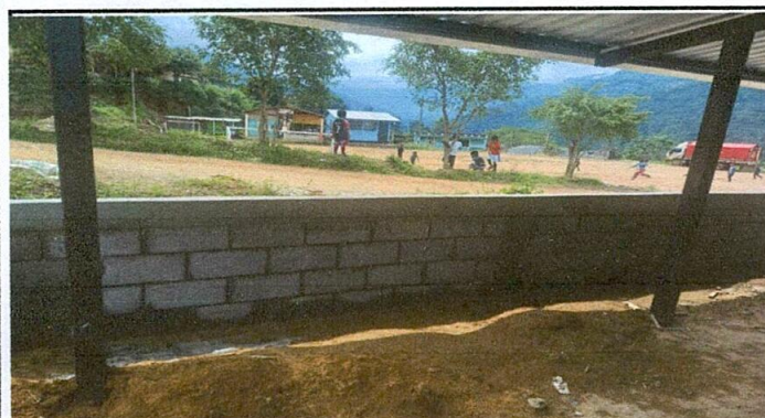
FOTO 3: MANTENIMIENTO A ESTRUCTURAS
