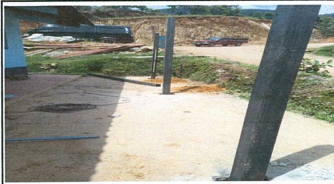
FOTO 2: SUSTITUCIÓN DE ESTRUCTURA
