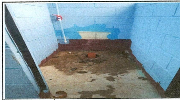
FOTO 6: SUSTITUCIÓN DE INODORO
