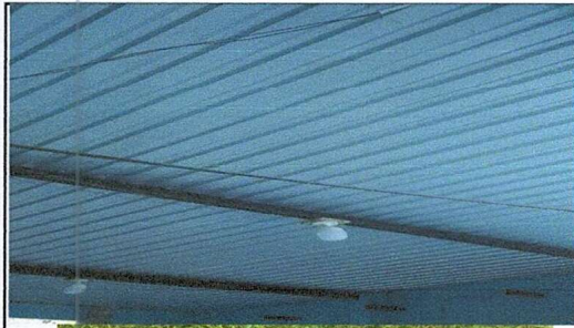
Foto 1: SUSTITUCIÓN DE LÁMINA POR LÁMINA TROQUELADA
