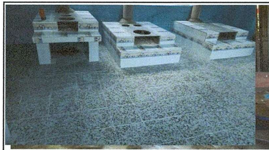
Foto 2: CONSTRUCCIÓN DE PLANCHA DE CONCRETO
