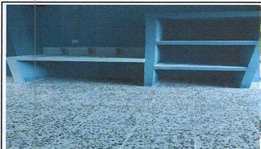
Foto 3: CONSTRUCCIÓN DE MUEBLES DE CONCRETO
