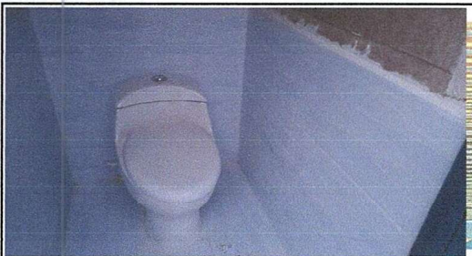
Foto 5: SUSTITUCIÓN DE BAÑOS Y COLOCACIÓN DE CERÁMICO
