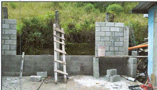
Foto 1: LEVANTADO DE MURO
