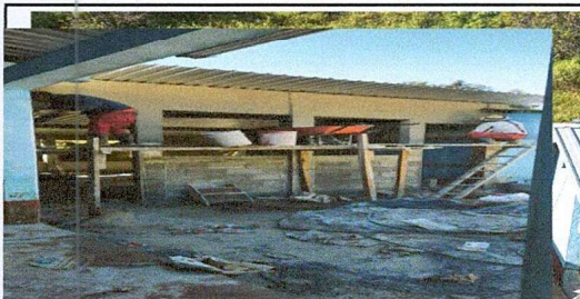
Foto 3: REPELLO DE PAREDES
