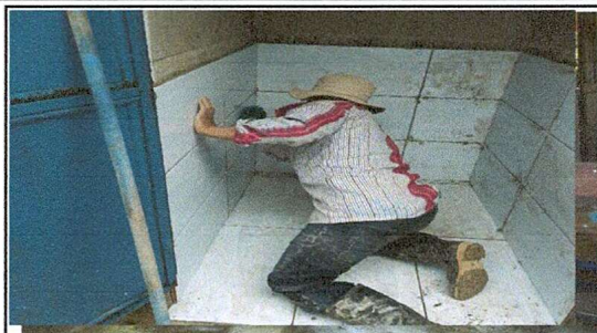
Foto 2: COLOCACIÓN DE CERÁMICO
