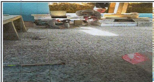
Foto 5: CONSTRUCCIÓN DE PISO EN COCINA
