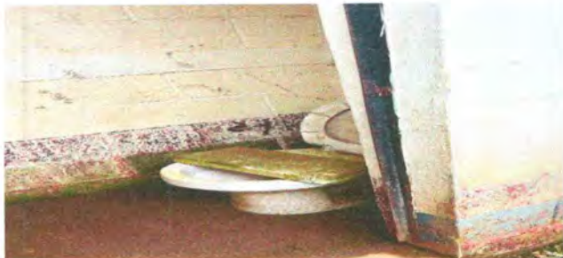
Foto 3: SUSTITUCION DE INODOROS
