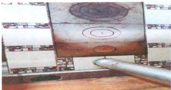
Foto1: SUSTITUCION DE PLANCHA DE METAL PARA ESTUFA RURAL
