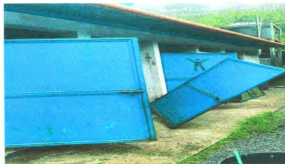
Foto 6: REPARACION DE PUERTAS DE SANITARIOS
