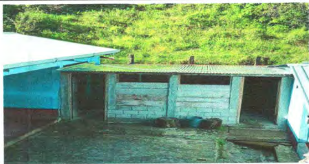
Foto 3: MEJORAMIENTO EN PAREDES DE COCINA
