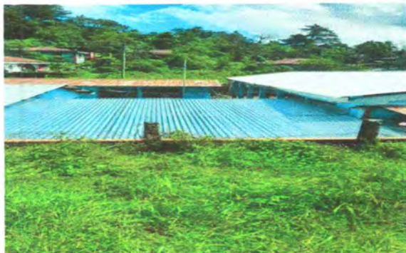
Foto1: SUSTITUCION DE LÁMINA POR LÁMINA TROQUELADA
