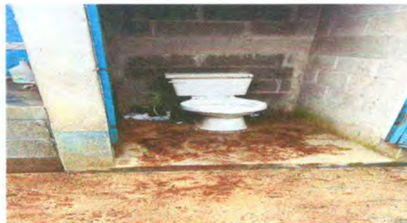
Foto 2: MEJORAMIENTO DE SANITARIOS
