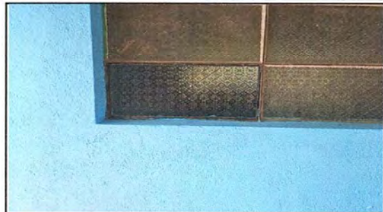
Foto 2: SUSTITUCIÓN DE VIDRIOS
