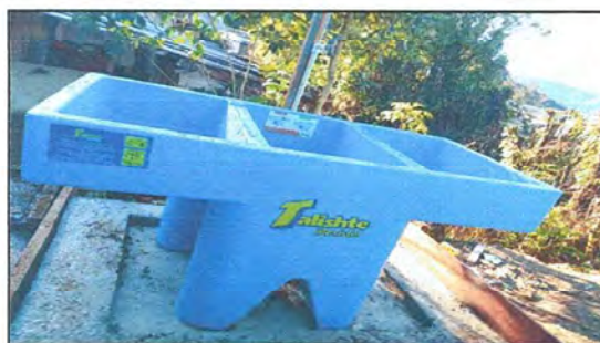
Foto 9: SUSTITUCIÓN DE PILA PLÁSTICA DE UN LAVADERO
