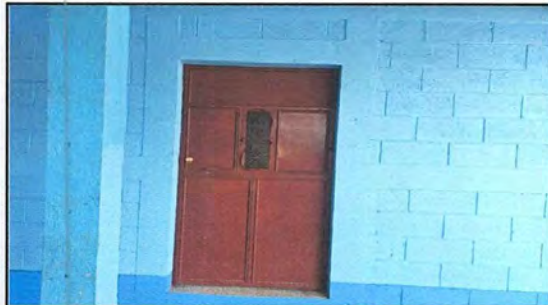
Foto 1: SUSTITUCIÓN DE PUERTAS DE METAL
