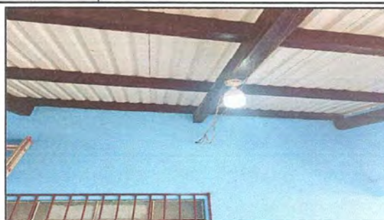
Foto 8: SUSTITUCIÓN DE FOCOS AHORRADORES
