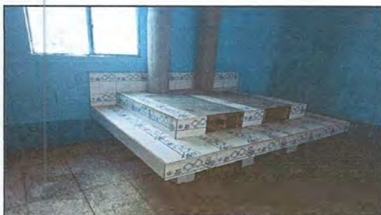
Foto 8: SUSTITUCIÓN DE ESTUFA RURAL (COMPLETA) INCLUYE CHIMENEA Y PLANCHA DE METAL
