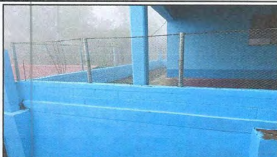
Foto 7: REPARACIÓN DE MURO PERIMETRAL CON MALLA Y TUVO
