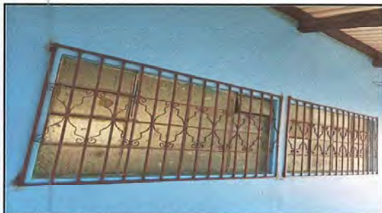
Foto 3: FABRICACIÓN DE BALCONES
