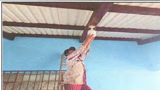
Foto 8: SUSTITUCIÓN DE FOCOS AHORRADORES
