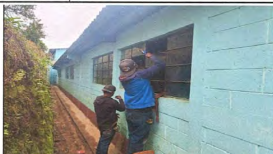
Foto 2: SUSTITUCION DE VIDRIOS
