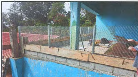
Foto 7: REPARACIÓN DE MURO PERIMETRAL CON MALLA Y TUVO
