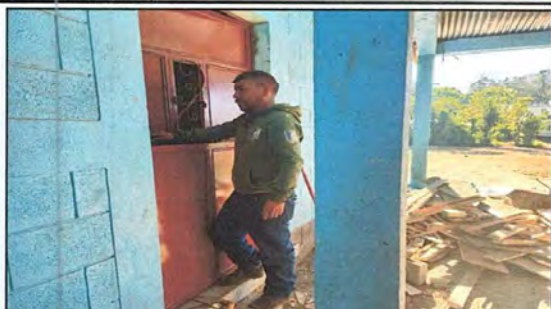
Foto 1: SUSTITUCION DE PUERTAS DE METAL
