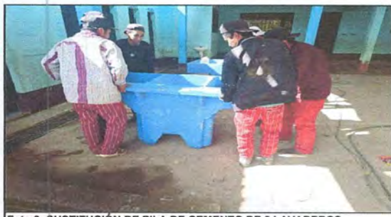
Foto 9: SUSTITUCIÓN DE PILA DE CEMENTO DE 2 LAVADEROS
