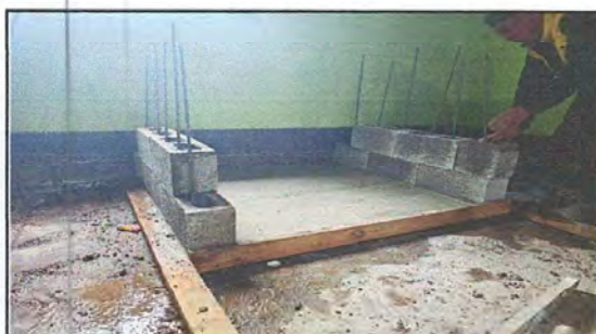
Foto 8: SUSTITUCIÓN DE ESTUFA RURAL (COMPLETA) INCLUYE CHIMENEA Y PLANCHA DE METAL
