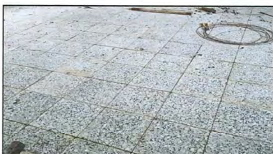
Foto 4: SUSTITUCIÓN DE PISO CERAMICO
