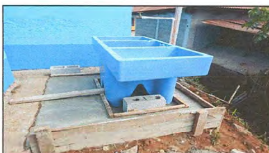
Foto 9: SUSTITUCIÓN DE PILA PLASTICA DE UN LAVADERO
