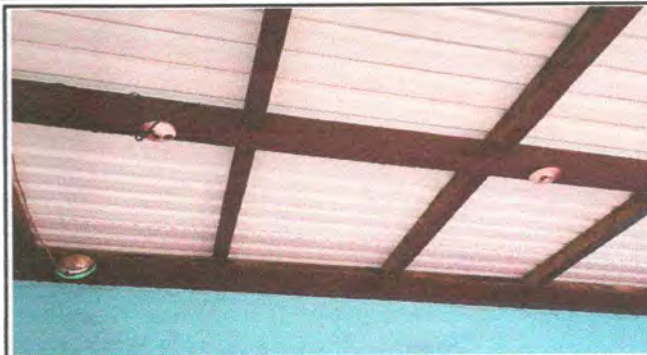
Foto 8: SUSTITUCIÓN DE FOCOS AHORRADORES
