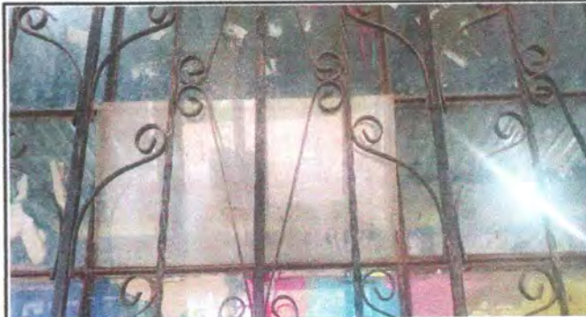
Foto 2: SUSTITUCION DE VIDRIOS
