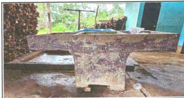
Foto 9: SUSTITUCIÓN DE PILA DE CEMENTO DE 2 LAVADEROS
