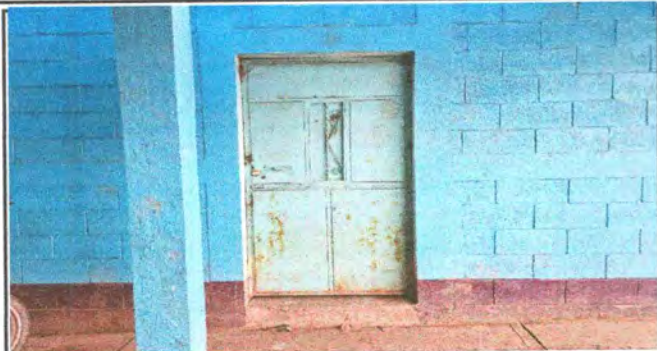
Foto1: SUSTITUCION DE PUERTAS DE METAL
