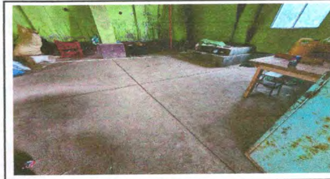
Foto 4: SUSTITUCIÓN DE PISO CERAMICO
