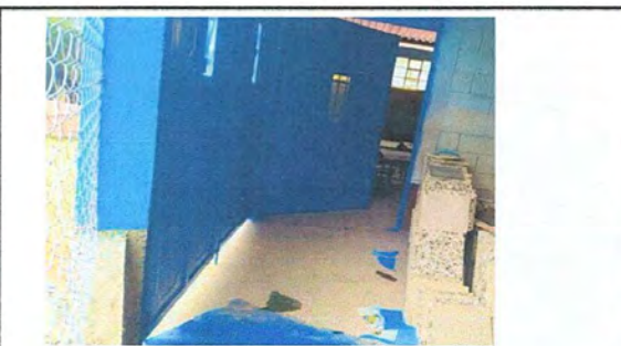
Foto 4: Sustrucción de puerta
