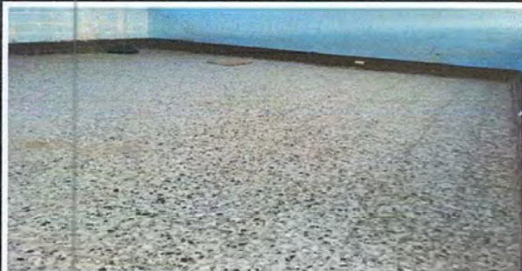
Foto 17: Sustrucción de piso granito
