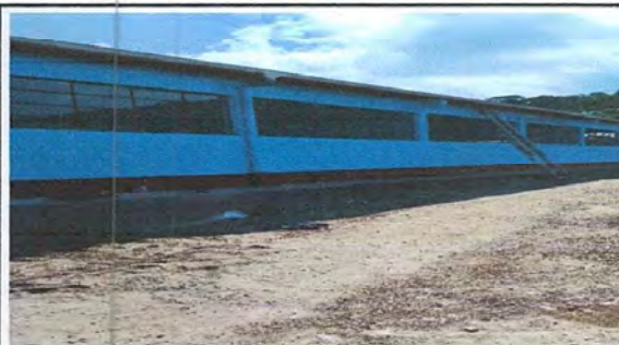
Foto 7: Pintura en muros exteriores e interiores
