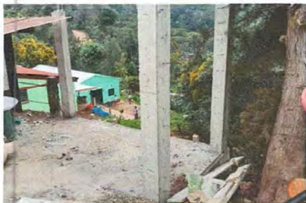
Foto 19: Sustitución de muro perimetral de baños
