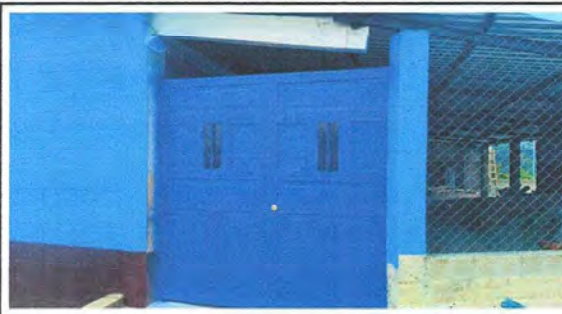
Foto 2: Sustrucción de portón de metal
