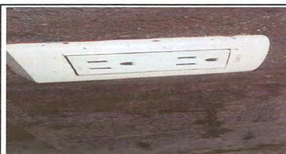
Foto 12: Reparación de sistema eléctrico
