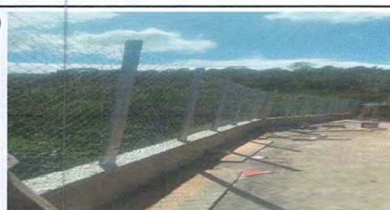
Foto 11: Reparación de muro perimetral de block con tubo hg y malla galvanizada, soleras intermedias y columnas
