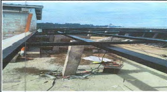
Foto 13: Sustrucción de estructura de soporte de madera ,por metal
