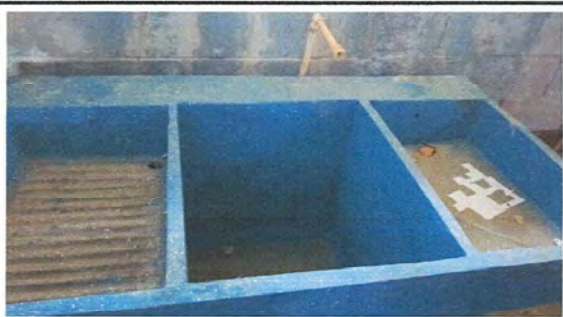
Foto 16: Sustrucción de pila de dos lavaderos
