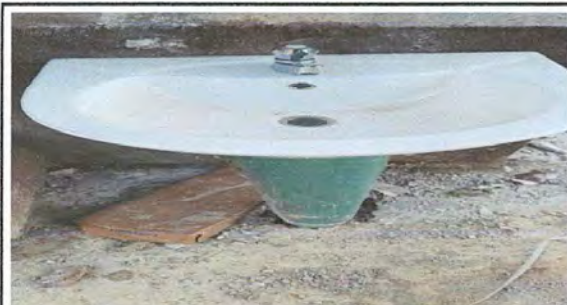
Foto 10: Sustitución de mezcladora lavamanos (contra llave, tubo de abasto)
