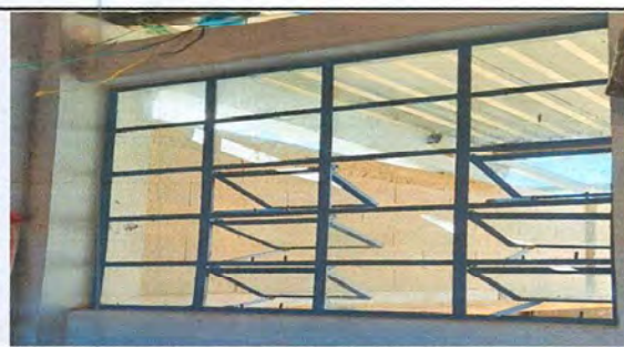
Foto 5: Mantenimiento a estructura de metal de ventana
