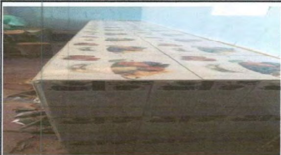
Foto 15: mejoramiento de azulejo en mesa de concreto
