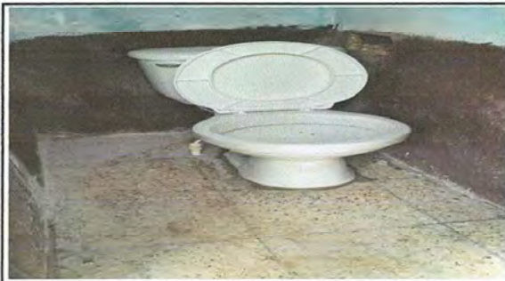
Foto 8: Sustitución de inodoro
