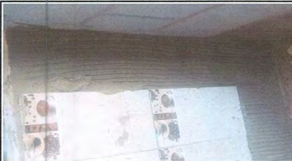
Foto 15: mejoramiento de azulejo en mesa de concreto
