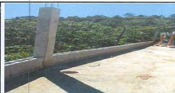
Foto 11: Reparación de muro perimetral de block con tubo hg y malla galvanizada, soleras intermedias y columnas
