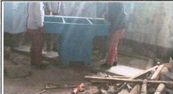
Foto 16: Sustrucción de pila de dos lavaderos
