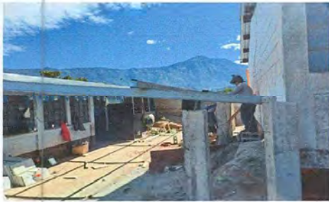
Foto 13: Sustrucción de estructura de soporte de madera ,por metal
