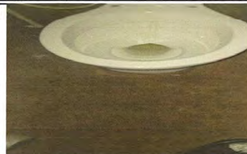
Foto 8: Sustitución de inodoro
