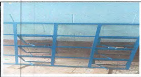
Foto 5: Mantenimiento a estructura de metal de ventana
