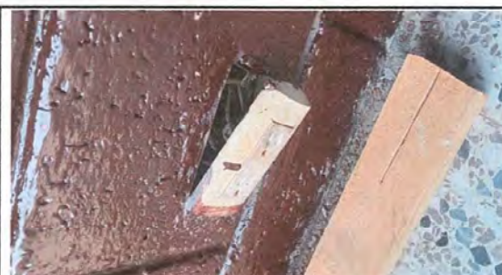
Foto 12: Reparación de sistema eléctrico
