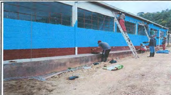
Foto7: Pintura en muros exteriores e interiores
