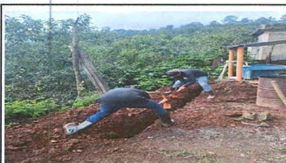
Foto 9:Sustitución de tubería PVC línea principal aguas negras
