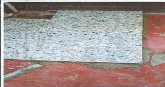
Foto 17: Sustrucción de piso granito
