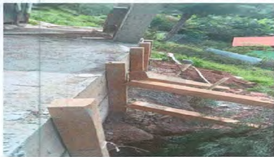
Foto 19: Sustitución de muro perimetral de baños
