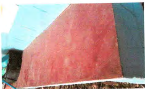
Foto 15:Mejoramiento de azulejo en mesa de concreto
