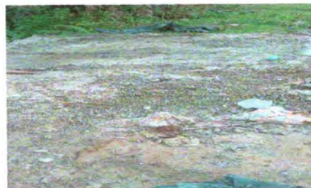
Foto 6: Sustitución de piso de torta de concreto
