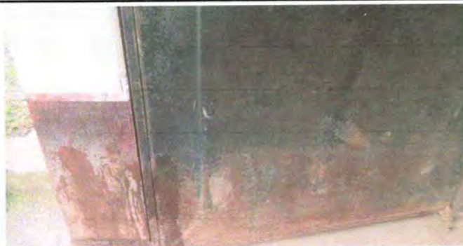
Foto 4: Sustitución de puerta
