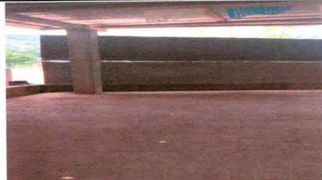
Foto 2: Sustitución de portón de metal
