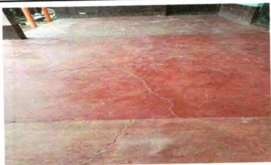
foto 17: Sustitución de piso ceramica
