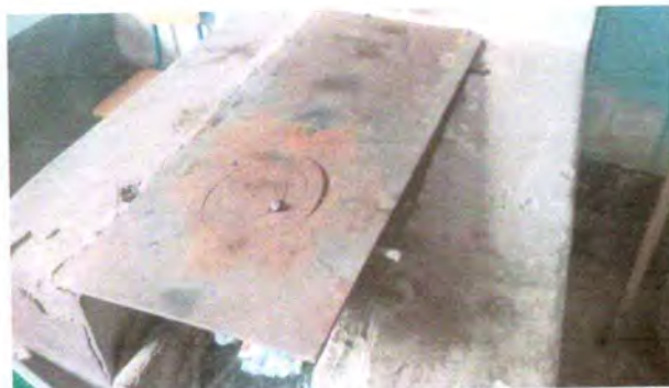
foto 14: sustitucion de plancha de metal de tres hornillas
