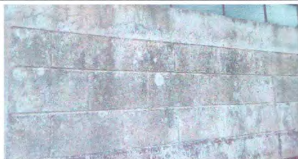
Foto 7: pintura en muros exteriores e interiores
