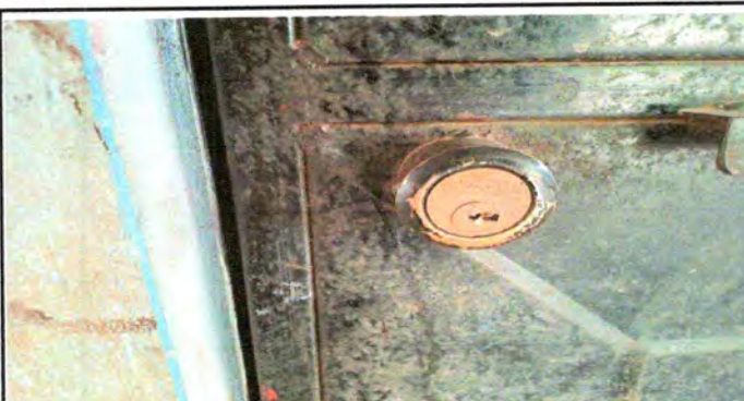
Foto 3: Sustitución de chapa
