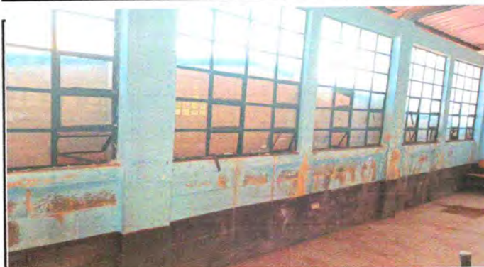
Foto 5: Mantenimiento a estructura de metal de ventana
