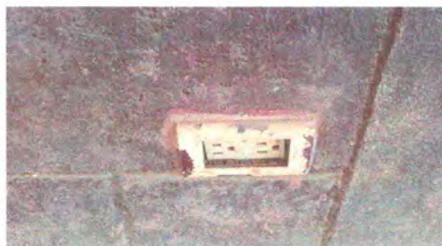
Foto 12: Reparación de sistema eléctrico.
