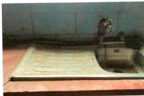
foto 16:Sustitución de pila de dos lavaderos
