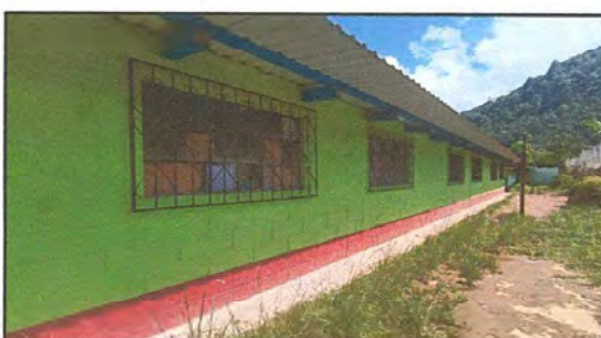
Foto 4: Ventanas nuevas del centro educativo
