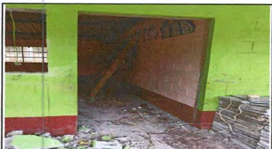
Foto 3: Desmonte de puertas
