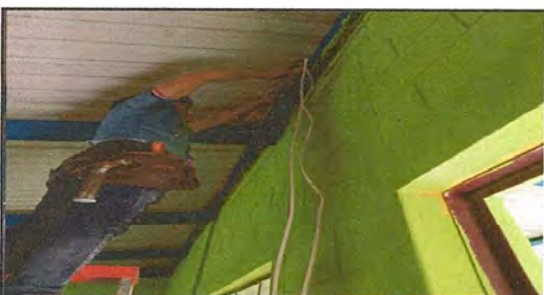
Foto 6: proceso de cambio de red eléctrica
