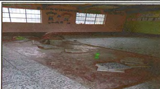
Foto 2: colocación de piso en el aula
