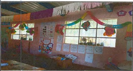
Foto 5: Ventanas de las aulas del centro educativo
