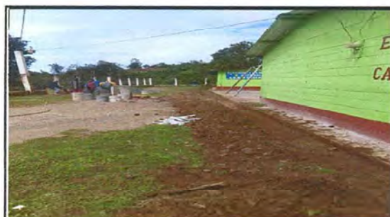
Foto 4: Limpieza donde se colocara la cuneta
