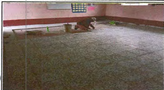
Foto 1: Colocación de piso en el aula
