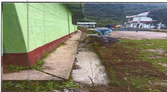
Foto 3: Proceso de colocación de la cuneta
