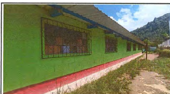
Foto 4: Ventanas de las aulas del centro educativo
