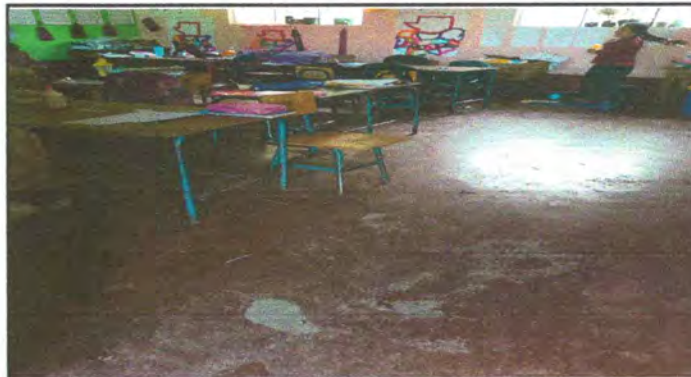
Foto 2: Piso de las aulas del centro educativo
