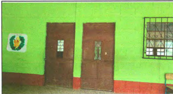
Foto 2: Puerta de las aulas
