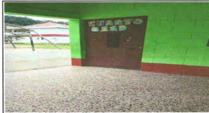
Foto 4: Puerta de las aulas del centro educativo
