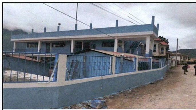
FOTO 4: REPELLO Y CERNIDO DE PAREDES
