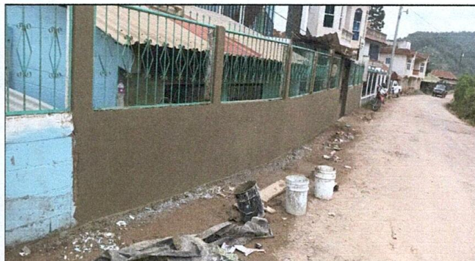
FOTO 4: REPELLO Y CERNIDO EN MUROS EXTERIORES
