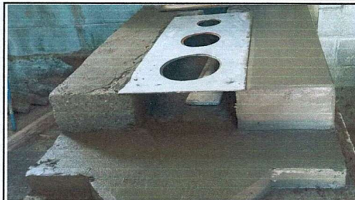
Foto 1: Sustrucción de plancha de metal de 3 hornillas
