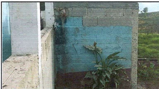
Foto 9: Mejoramiento de pared de block
