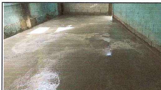
Foto 4: Sustrucción de piso de torta de concreto
