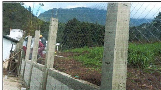
Foto 10: Reparación de muro de contención
