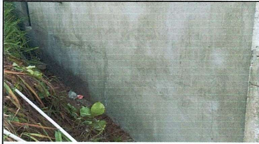
Foto 13: Repello liso para pared de block
