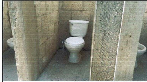
Foto 8: Sustrucción de letrinas por baños labables
