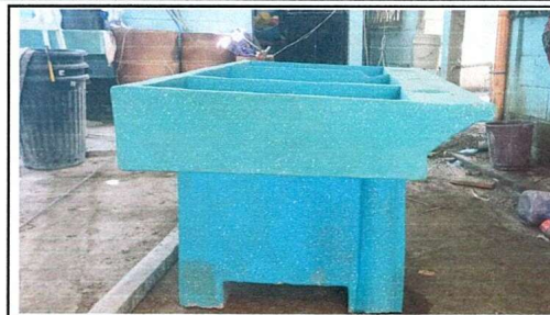
Foto 2: Sustrucción de pila de cemento de dos lavaderos
