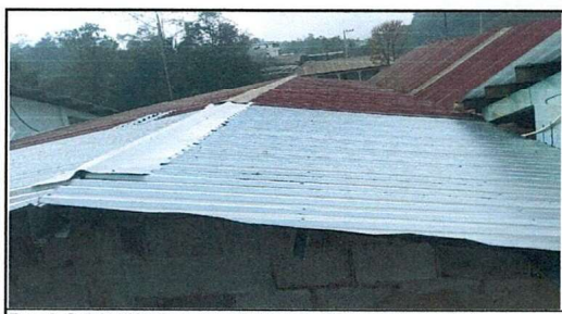
Foto 6: Sustrucción de capote de lámina para lámina troquelada
