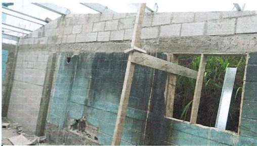
Foto 3: Mejoramiento de pared de block (cocina)
