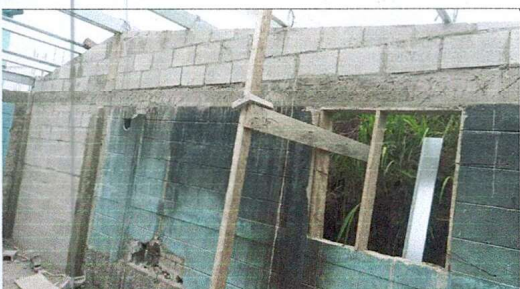
Foto 3: Mejoramiento de pared de block (cocina)
