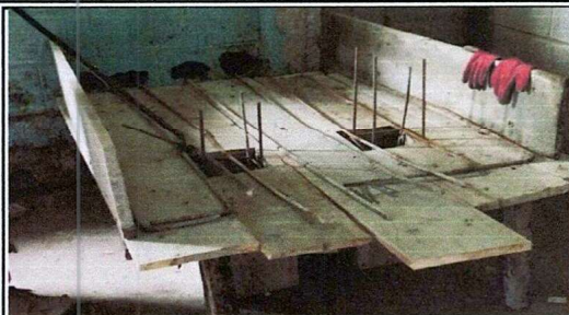
Foto 1: Sustrucción de plancha de metal de 3 hornillas
