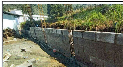
Foto 10: Reparación de muro de Perimetral
