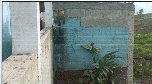
Foto 9: Mejoramiento de pared de block (sanitarios)
