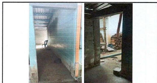
Foto 12: Sustrucción de puertas
