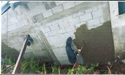
Foto 13: Repello liso para pared de block
