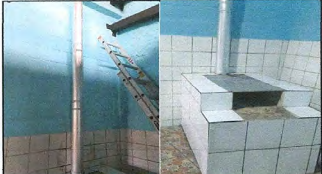
FOTO 8: SUSTITUCIÓN DE CHIMENEA DE METAL
