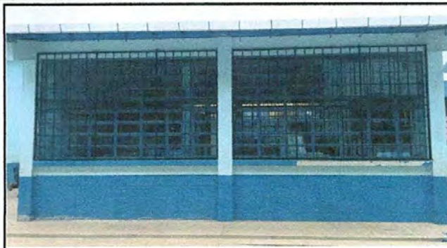
FOTO 2: SUSTITUCIÓN DE BALCONES DE METAL
