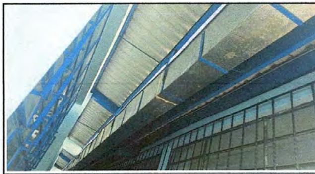
FOTO 6: SUSTITUCIÓN DE SOPORTE
