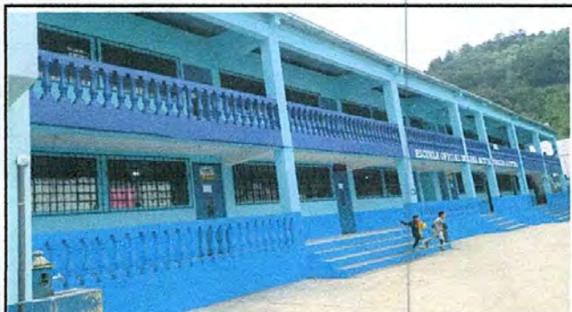
FOTO 1: PINTURA EN MUROS EXTERIORES E INTERIORES
