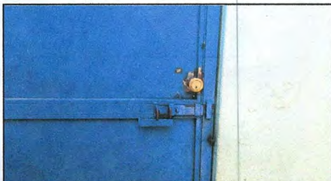
FOTO 3: SUSTITUCIÓN DE CHAPA
