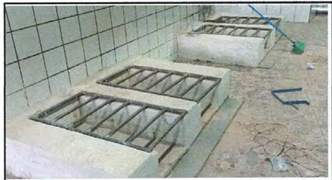
FOTO 12: SUSTITUCIÓN DE ESTUFA RURAL
