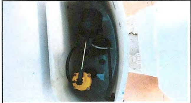
FOTO 10: SUSTITUCIÓN DE ACCESORIOS INODORO
