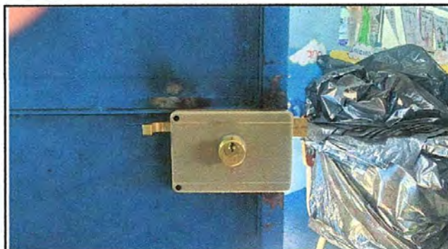
FOTO 4: SUSTITUCIÓN DE CHAPAS
