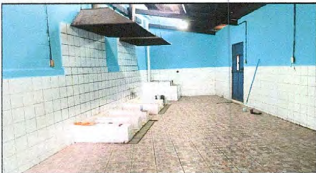
FOTO 11: SUSTITUCIÓN DE piso cerámico
