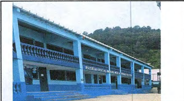
FOTO 9: SUSTITUCIÓN DE CANAL DE PVC
