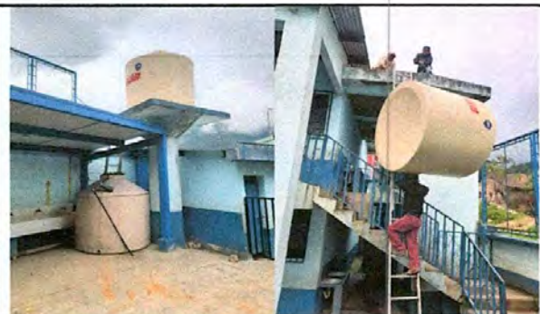
FOTO 7: SUSTITUCIÓN DE DEPOSITO DE AGUA
