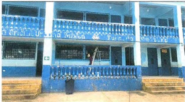
FOTO 1: PINTURA EN MUROS EXTERIORES E INTERIORES
