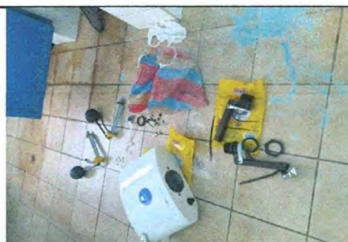
FOTO 10: SUSTITUCIÓN DE ACCESORIOS INODORO
