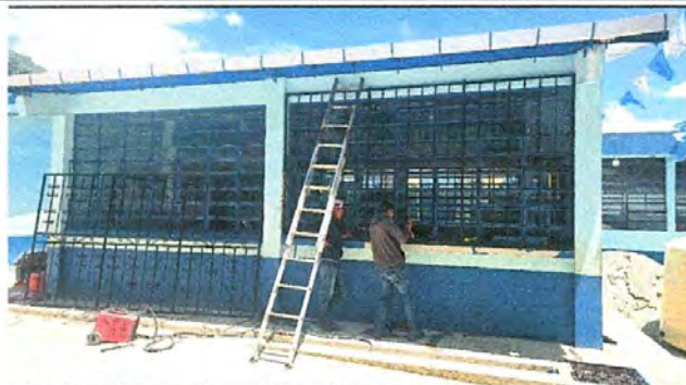
FOTO 2: SUSTITUCIÓN DE BALCONES DE METAL
