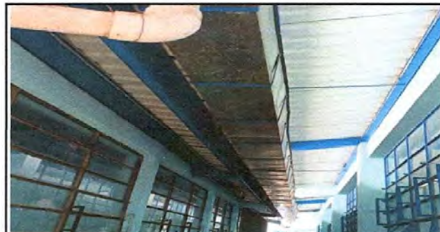
FOTO 6: SUSTITUCIÓN DE SOPORTE
