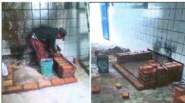
FOTO 12: SUSTITUCIÓN DE ESTUFA RURAL
