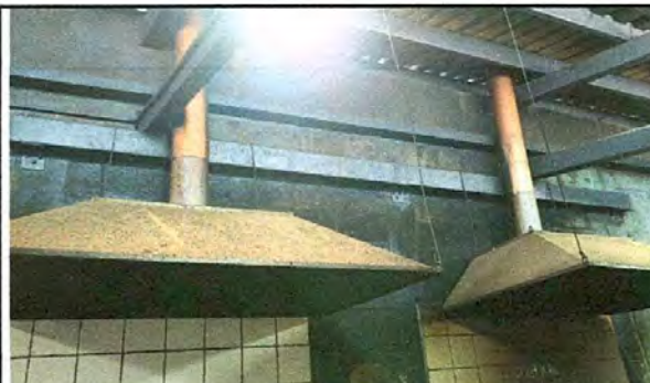
FOTO 8: SUSTITUCIÓN DE CHIMENEA DE METAL
