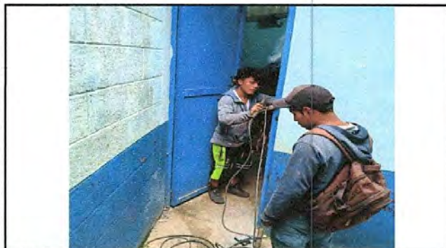
FOTO 3: SUSTITUCIÓN DE CHAPA
