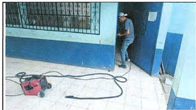
FOTO 4: SUSTITUCIÓN DE CHAPAS
