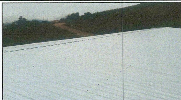
FOTO 1: SUSTITUCIÓN DE LÁMINA
