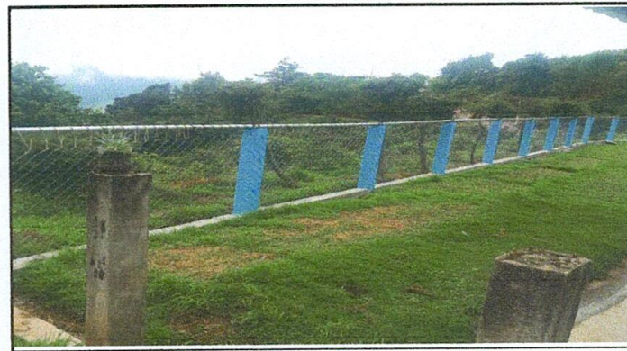
FOTO 4: SUSTITUCION DE MAYA.
