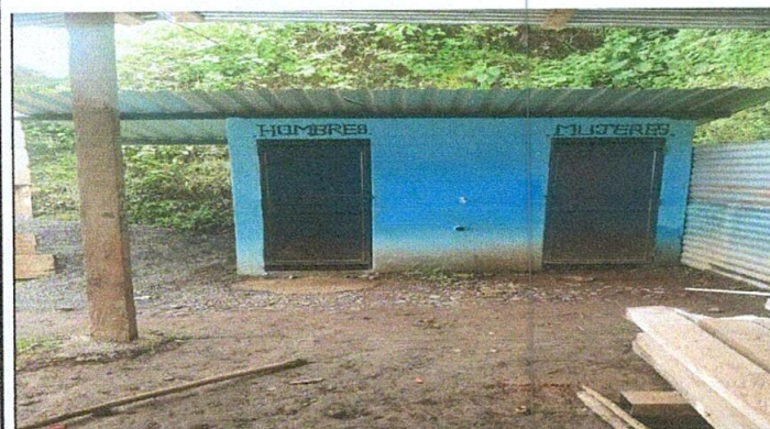
FOTO 3: SUSTITUCIÓN DE PUERTAS EN SERVICIO SANITARIO
