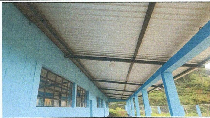
FOTO 2: SUSTITUCIÓN DE SOPORTE DE MADERA, POR METAL
