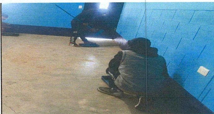
FOTO 5: PINTURA EN MUROS EXTERIORES E INTERIORES
