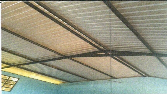
FOTO 1: SUSTITUCIÓN DE LÁMINA
