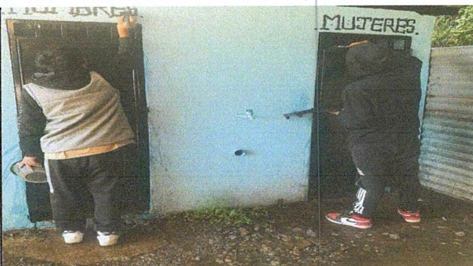
FOTO 3: SUSTITUCIÓN DE PUERTAS EN SERVICIO SANITARIO
