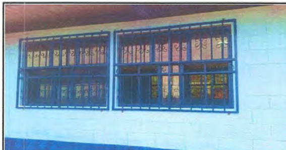
Foto 6: SUSTITUCIÓN DE BALCONES
