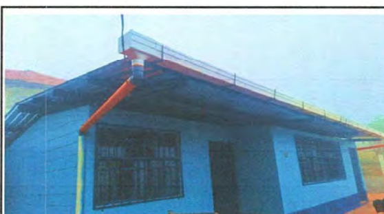
Foto 10: SUSTITUCIÓN DE CANALES Y BAJADAS DE AGUA
