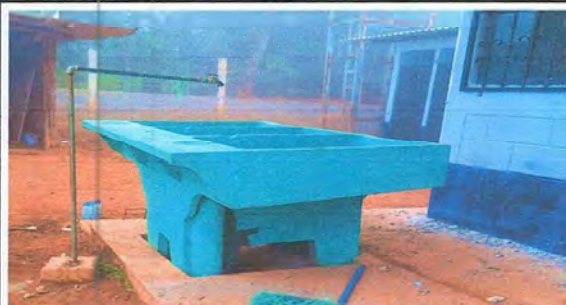
Foto 7: SUSTITUCIÓN DE PILA DE COCINA
