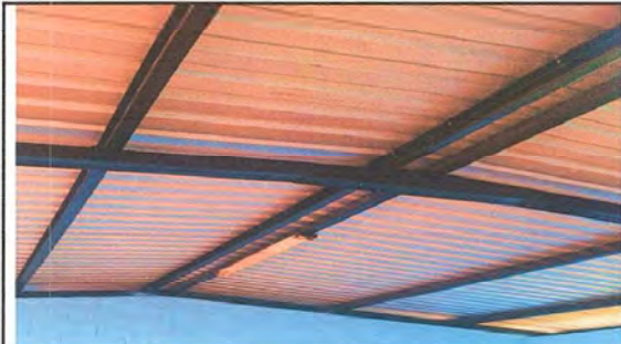
Foto 2: MANTENIMIENTO DE ESTRUCTURA DE TECHO
