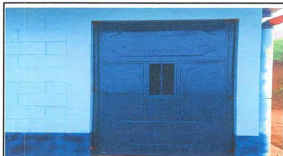
Foto 4: SUSTITUCIÓN DE PUERTAS
