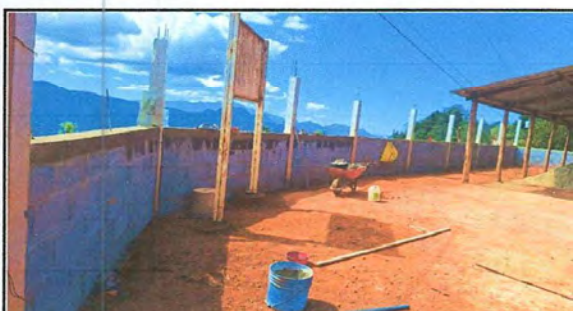
Foto 9: SUSTITUCIÓN DE MURO PERIMETRAL
