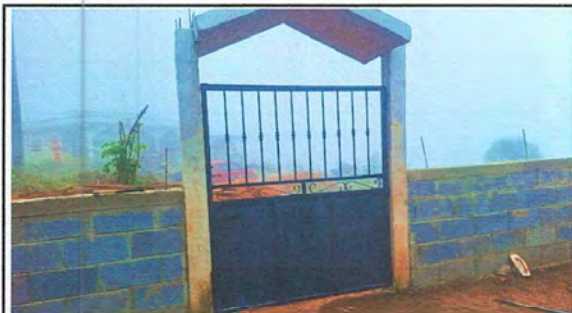
Foto 3: SUSTITUCIÓN DE PORTÓN
