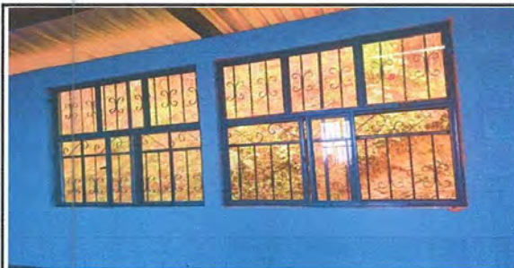
Foto 5: SUSTITUCIÓN DE VENTANAS
