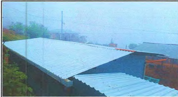
Foto 1: SUSTITUCIÓN DE TECHO DE LÁMINA
