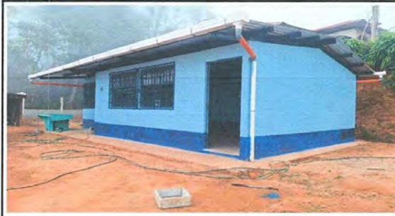
Foto 8: PINTURA DE MUROS EXTERIORES E INTERIORES
