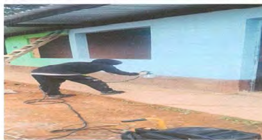
Foto 8: PINTURA DE MUROS EXTERIORES E INTERIORES
