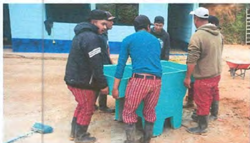
Foto7: SUSTITUCIÓN DE PILA DE COCINA
