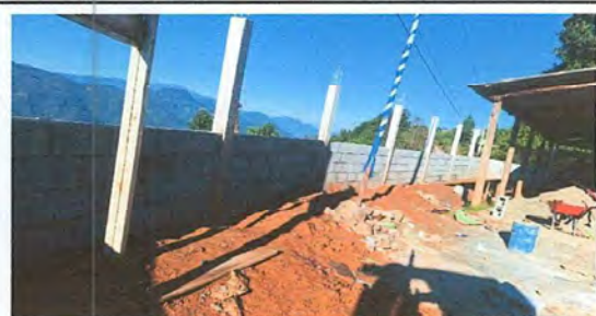
Foto 9: SUSTITUCIÓN DE MURO PERIMETRAL
