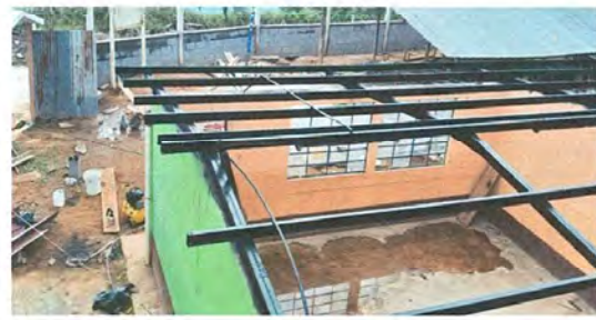
Foto 2: MANTENIMIENTO DE ESTRUCTURA DE TECHO
