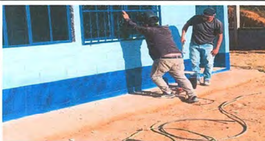
Foto 6: SUSTITUCIÓN DE BALCONES
