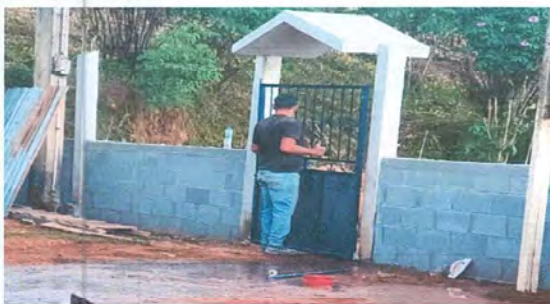
Foto 3: SUSTITUCIÓN DE PORTÓN
