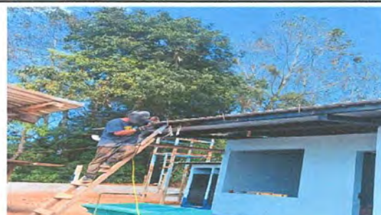
Foto 10: SUSTITUCIÓN DE CANALES Y BAJADAS DE AGUA
