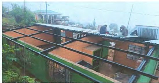
Foto 1: SUSTITUCIÓN DE TECHO DE LÁMINA
