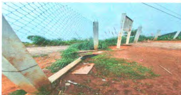
Foto 9: SUSTITUCIÓN DE MURO PERIMETRAL
