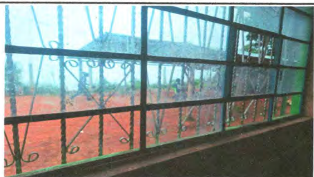
Foto 5: VENTANAS A SUSTITUIR
