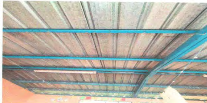
Foto 2: MANTENIMIENTO DE ESTRUCTURA DE TECHO
