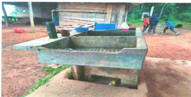
Foto7: SUSTITUCIÓN DE PILA DE COCINA
