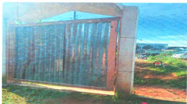
Foto 3: SUSTITUCIÓN DE PORTÓN
