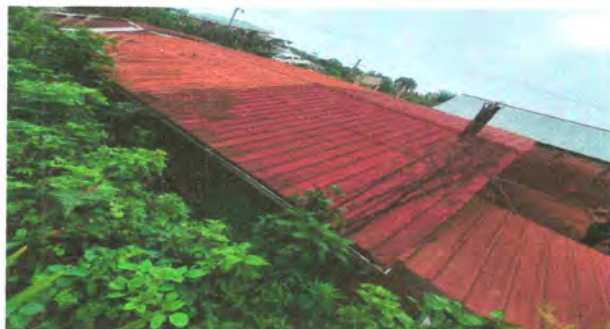
Foto1: SUSTITUCIÓN DE TECHO DE LÁMINA
