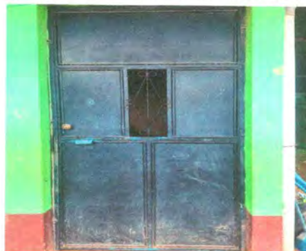
Foto 4: SUSTITUCIÓN DE PUERTAS
