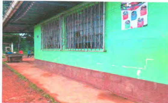
Foto 8: PINTURA DE MUROS EXTERIORES E INTERIORES
