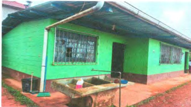
Foto 10: SUSTITUCIÓN DE CANALES Y BAJADAS DE AGUA
