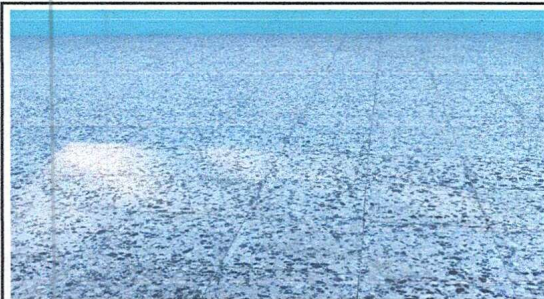
Foto 1: Sustrucción de piso de granito en un aula.
