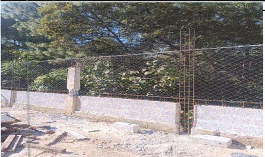
Foto 3: Reparación de muro y enmallado con tubo galvanizado.
