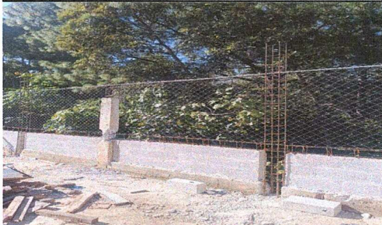
Foto 4: Reparación de muro y enmallado con tubo galvanizado.
