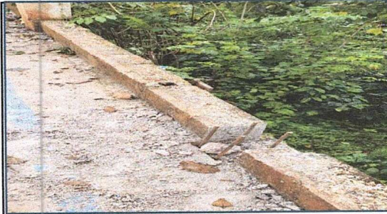
Foto 1: Reparación de muro perimetral
