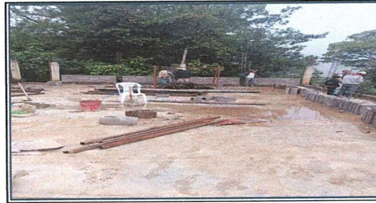
Foto 6: inicio muro perimetral al fondo
