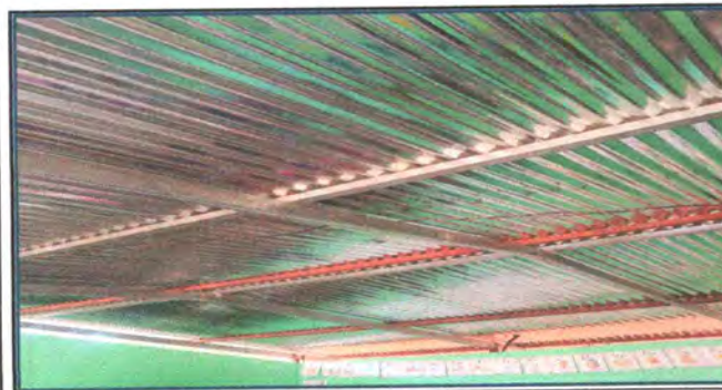
Foto 5: sustitución de lámina por lámina troquelada
