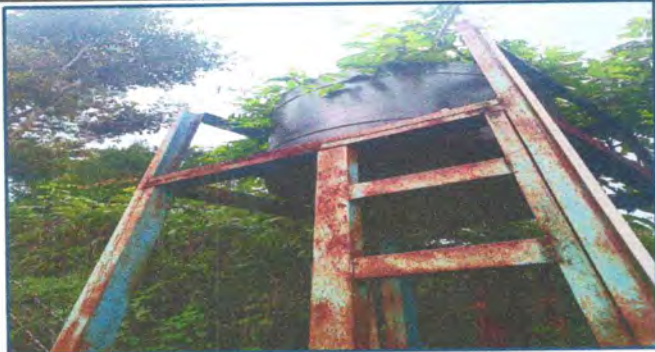
Foto13: Sustitución de depósito de agua
