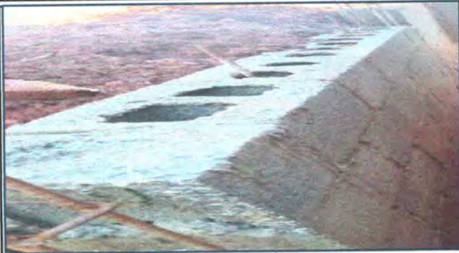
Foto 1: Reparación de muro perimetral
