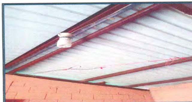
Foto 12: reapación del sistema eléctrico
