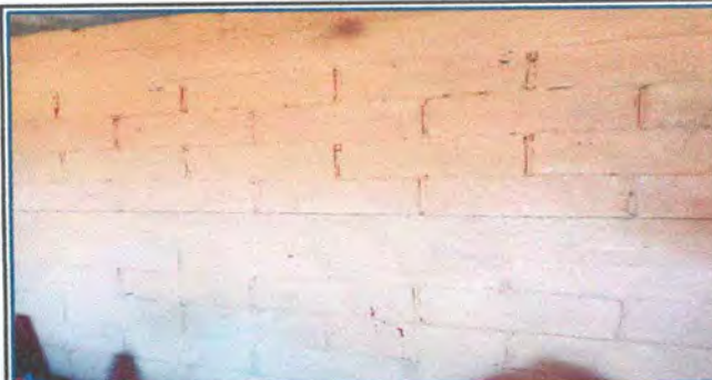
Foto 10: pintura en muro exteriores e interiores
