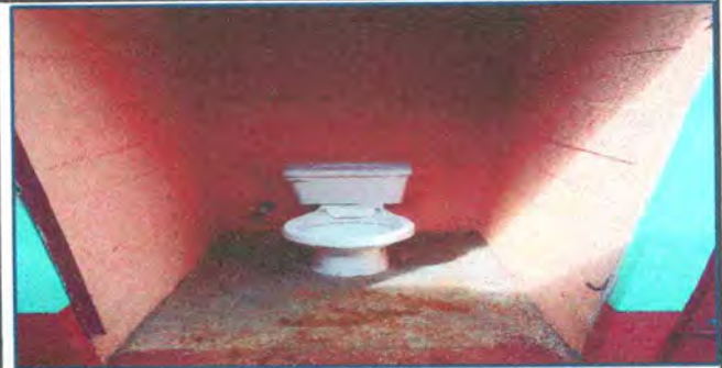
Foto 15: sustitución de puerta en servicio sanitario
