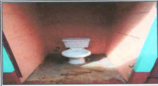
Foto 4: Sustitución de inodoro
