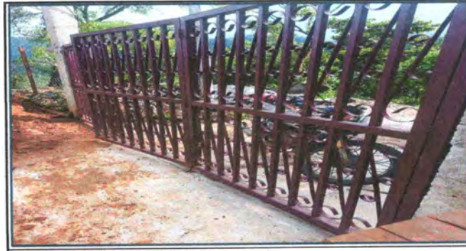
Foto 6: mantenimiento a portones de metal
