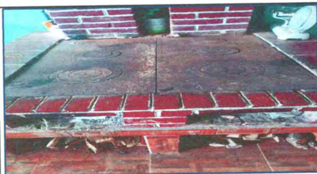
Foto 9: sustitucion de plancha de metal
