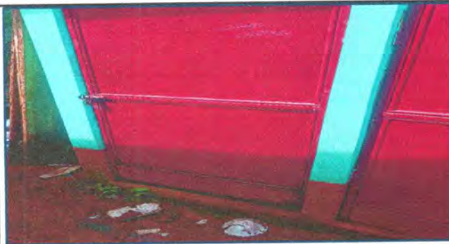
Foto 16: matenimiento de puertas
