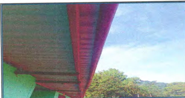
Foto 11: sustitucion de canal PVC
