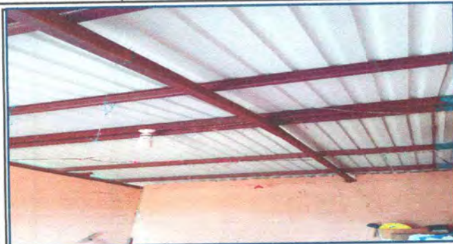
Foto7: Sustitución de estructura de soporte de metal
