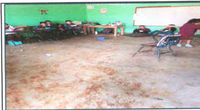
Foto 3: sustitución de piso cerámico
