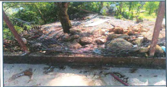
Foto 2: Reparación de enmallado
