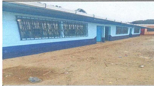
FOTO 2: PINTURA EN MUROS EXTERIORES E INTERIORES
