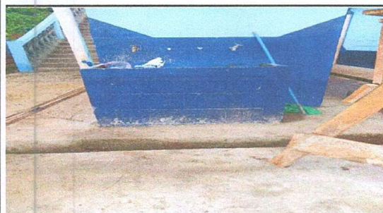
Foto 3: APLICACIÓN DE AZULEJO EN LAVAMANOS
