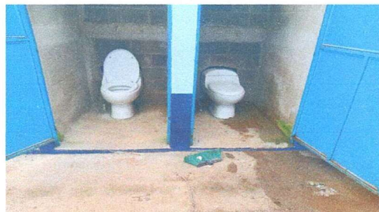
Foto 4: SUSTITUCIÓN DE INODOROS Y PISO ANTIDESLIZANTE
