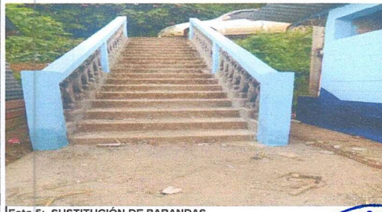
Foto 5: SUSTITUCIÓN DE BARANDAS
