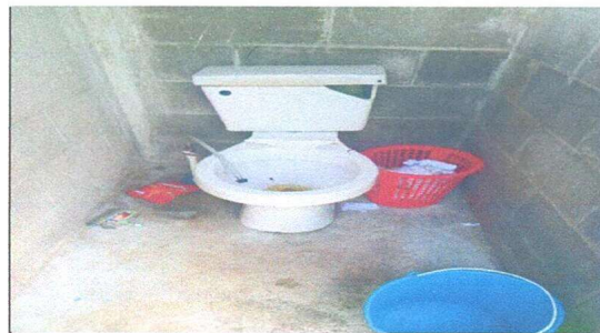
Foto 4: SUSTITUCIÓN DE INODOROS Y PISO ANTIDESLIZANTE
