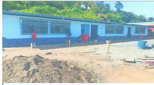
FOTO 2: PINTURA EN MUROS EXTERIORES E INTERIORES
