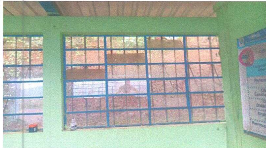
FOTO 1: SUSTITUCIÓN DE VIDRIOS
