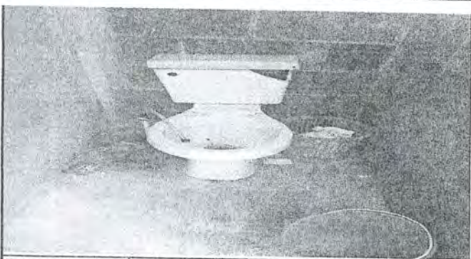
Foto 4: SUSTITUCIÓN DE INODOROS Y PISO ANTIDESLIZANTE
