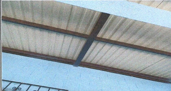
FOTO 2: MANTENIMIENTO DE ESTRUCTURA DE METAL
