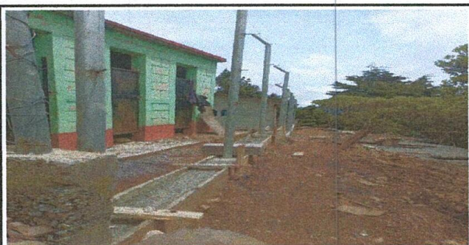
FOTO 5: REPARACIÓN DE MURO PERIMETAL CON TUBO HG Y MALLA
