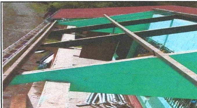
FOTO 2: MANTENIMIENTO DE ESTRUCTURA DE METAL
