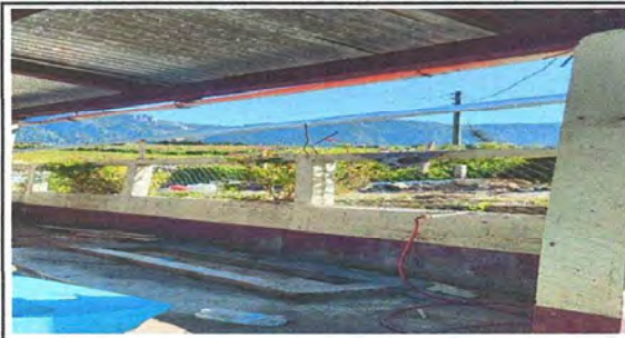
Foto 4: Sustitución de soporte de techo de madera por metal en patio.
