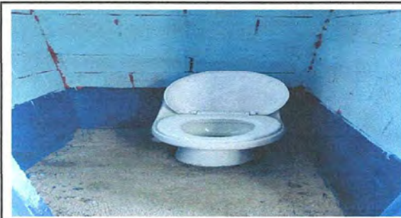
Foto 4: SUSTITUCION DE INODOROS
