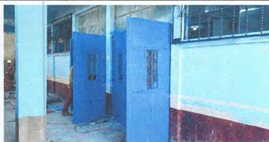
Foto 5: MANTENIMIENTO A PUERTAS
