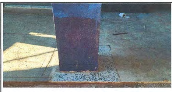
Foto 6: REPARACION DE PISO
