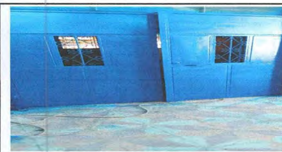
Foto 5: MANTENIMIENTO A PUERTAS
