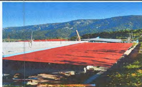
Foto1: SUSTITUCION DE LAMINA POR LAMINA TROQUELADA
