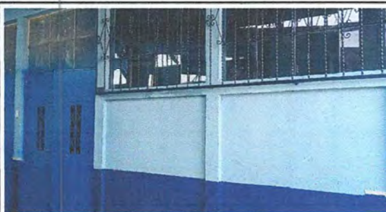
Foto 3: PINTURA DE MUROS EXTERIORES
