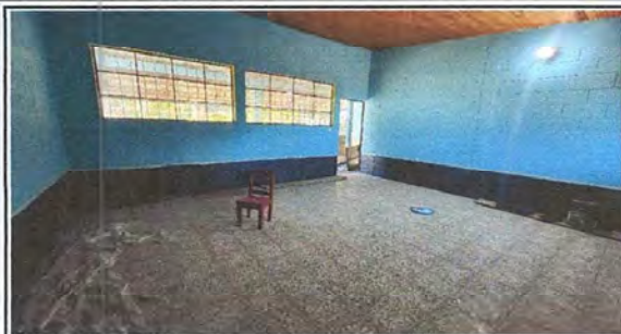
Foto1: SUSTITUCION DE PISO DE TORTA POR PISO GRANITO PARA AULAS
