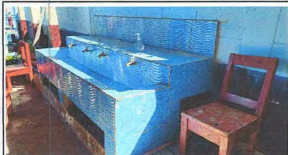
Foto 3: Sustitución de otro lavamanos
