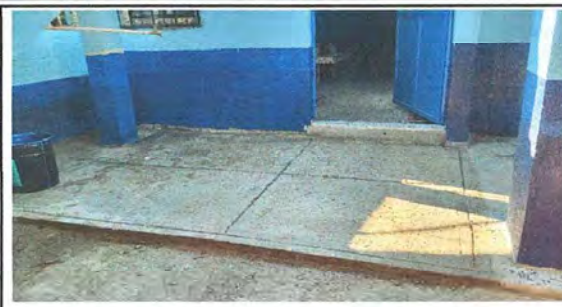
Foto 2: REPARACION DE LOSA DE PATIO
