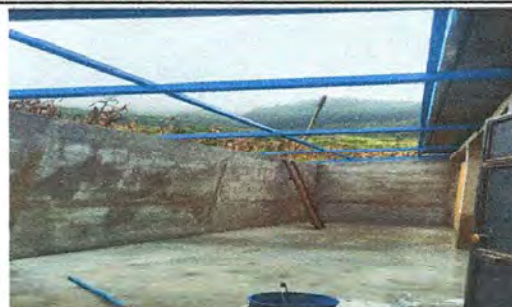
Foto 2: SUSTITUCION DE ESTRUCTURA DE SOPORTE DE ESTRUCTURA DE MADERA POR METAL
