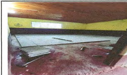
Foto 2: SUSTITUCION DE PISO POR PISO GRANITO
