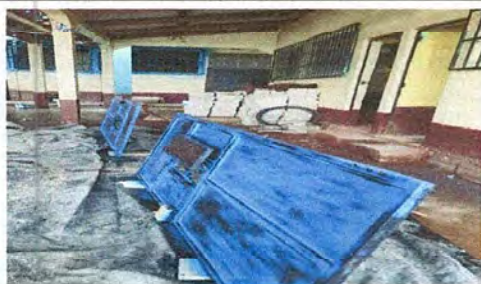
Foto 5: MANTENIMIENTO A PUERTAS
