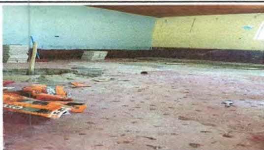
FOTO1: SUSTITUCION DE PISO DE TORTA POR PISO GRANITO PARA AULAS
