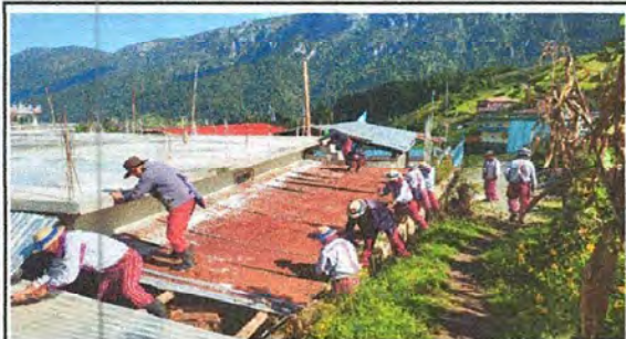
Foto 1: SUSTITUCION DE LAMINA POR LAMINA TROQUELADA
