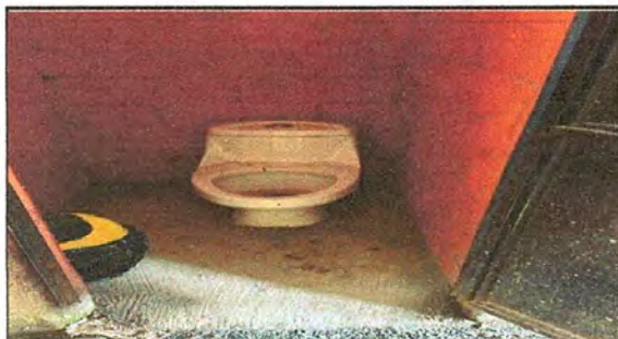
Foto 4: SUSTITUCION DE INODOROS
