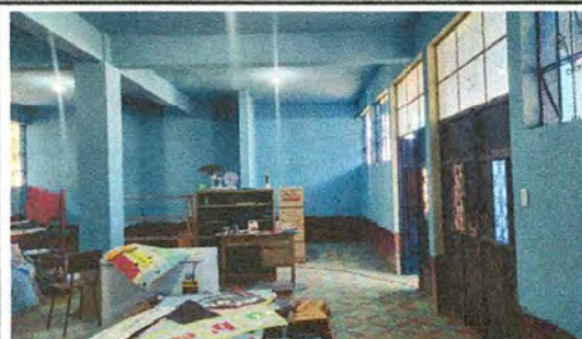
Foto 4: PINTURA DE MUROS INTERIORES
