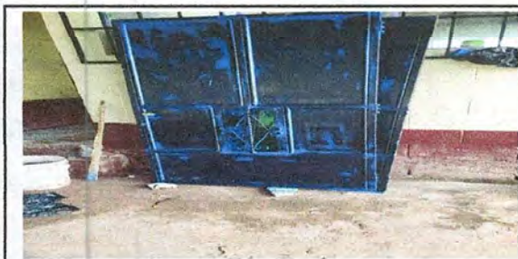
Foto 5: MANTENIMIENTO A PUERTAS
