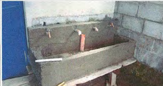
Foto 6: AZULEJO EN AREA DE LAVAMANOS
