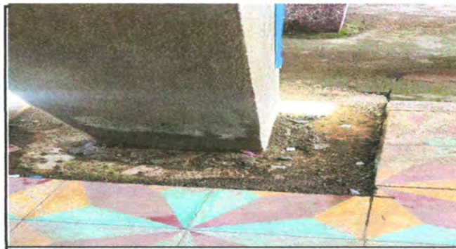
Foto 6: REPARACION DE PISO
