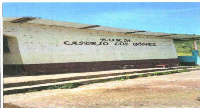
Foto 3: PINTURA DE MUROS EXTERIORES
