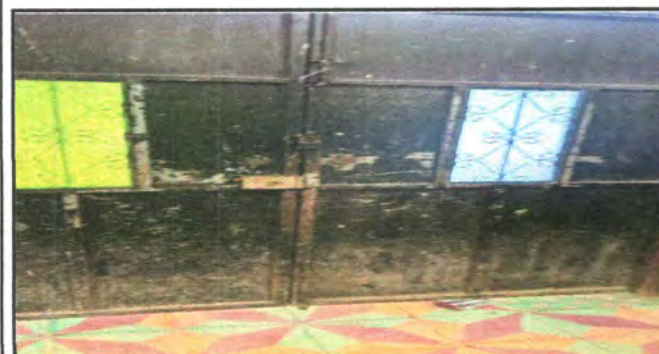
Foto 5: MANTENIMIENTO A PUERTAS
