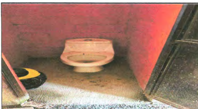
Foto 4: SUSTITUCION DE INODOROS
