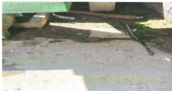
Foto 2: REPARACION DE LOSA DE PATIO
