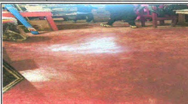
Foto 2: SUSTITUCION DE PISO POR PISO GRANITO
