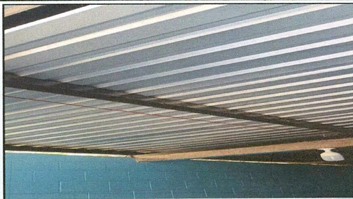
Foto 2: Estructura de Techo
