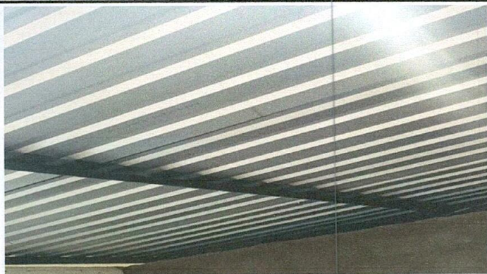
Foto 1: Cubierta de lámina
